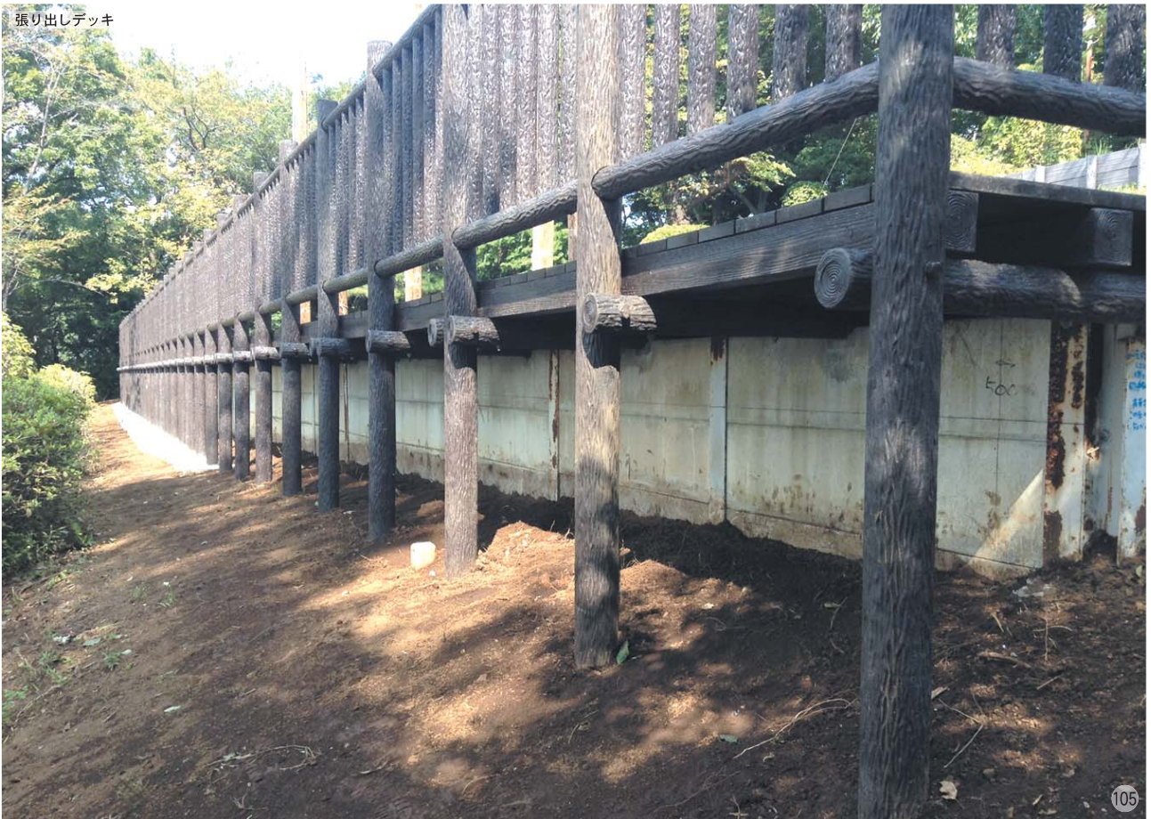
張り出しデッキ・床
