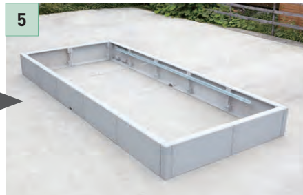
5 「レベル」や「通り」を見ながら、ボルト類を本締めします。(A-2)
