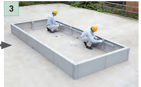
3 連結部を補強し、直線の通りを出します。(A-2、D-1、D-2)
