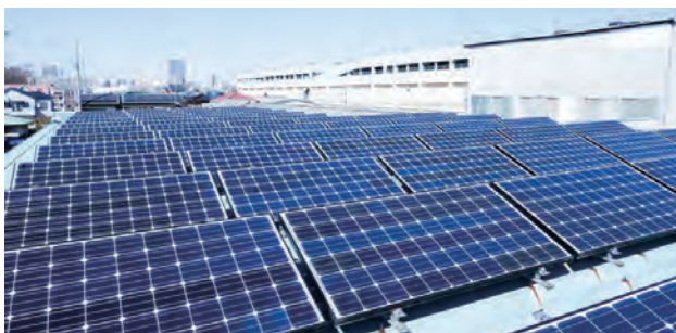
埼玉工場屋上
