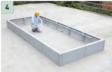
4 パネルが外側に膨れないよう「ワイヤー」または「フラットバー」などで補強します。*「ワイヤー」「フラットバー」はオプションです。(F、G)
