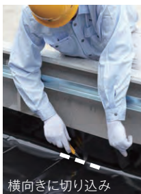
9 水がパネル外に抜けるように、耐根補助シートに切り込みを入れます。
