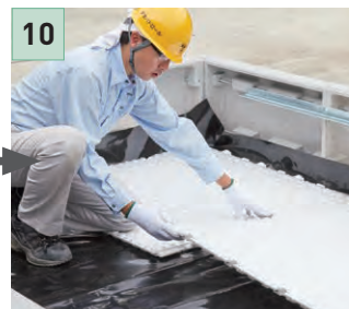
10 耐根補助シートの上に排水パネルを敷きます。
