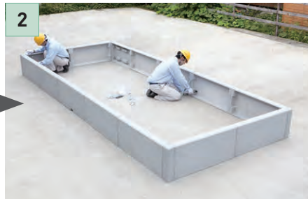
2 パネル連結部のボルトを仮締めします。(A-1) ※補強ベース(B)を使用する場合は、この段階でアームを取り付けてください。
