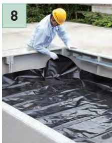
8 耐根補助シートを敷きます。「耐根補助シート」は15cm程端を立ち上げてください。
