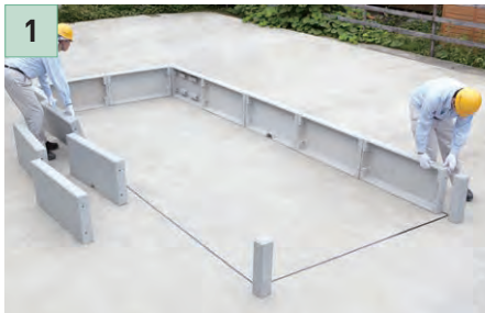
1 設置場所を墨出し、パネルを仮置きします。
