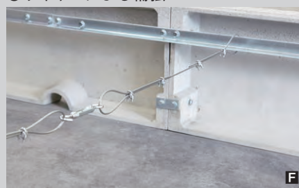
「通り」を確認後、補強ベースを床面に接着。
