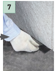
7 不陸調整が必要な場合は専用ゴムスペーサーを敷き込みます。
