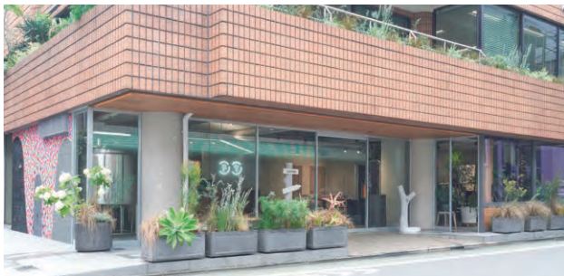
トーシンコーポレーション本社
