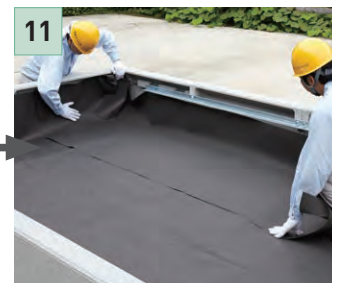
11 透水シートを敷き、人工土壌を敷きこんで作業は完了です。
