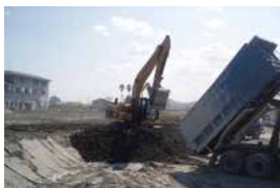
中和処理土の自ら利用
