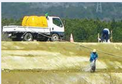
タンクと動力噴射器をトラックに積載して希釈液を作成し法面に散布
