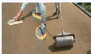
施工面の水が引いた後、乾かないうちに転圧してください。コテなどを使用する場合は施工面を叩いて転圧します。
