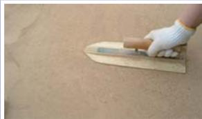
敷き均しは、プラコテで転圧しながら施工厚まで敷き均します。ローラーを使用する場合は、とんぼ等を用いて敷き均し、ローラーで転圧をかけます。荷重が大きく材料が逃げる場合は、コンパネなどを敷いた上から転圧をかけて下さい。ムラが出来た場合は、プラ鍬などで直して下さい。押さえた面を刷毛やほうきなどで軽く荒らして仕上げます。刷毛引きする事でコテやローラー跡を消し、表面の粒子の偏りを無くし均一に仕上げます。
