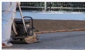
碎石を100mm以上敷き転圧機を用いて締め固め十分に強い地盤を作ります。
