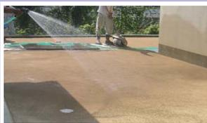
じょうろなどで表面が平均に濡れる程度の水を、冠水や材料流失しないように数回散水します。
