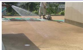
転圧した面を壊さないように移動しながら数回に分けて散水します。
