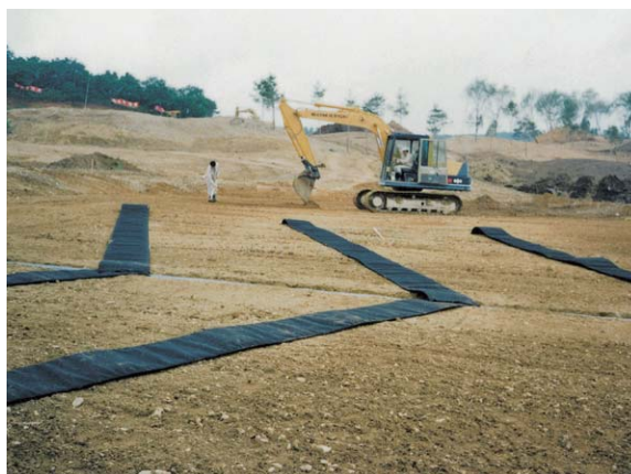
運動施設排水工
