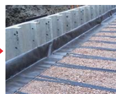
④鋼製枠と内壁シートの設置
