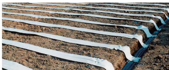
盛土内水平排水
