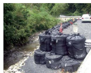
対向車待ち受け用仮設待避所
