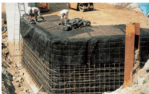
補強盛土工法 (RRR工法)
