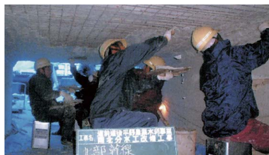
ボックスカルバートの頂版補強
