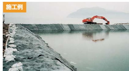
遮水シート工のクッション材
