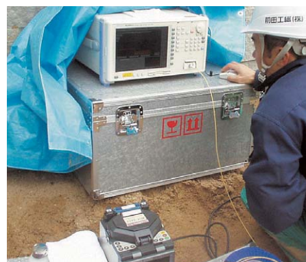
盛土内の長期的な計測・健全度評価（右：計測時の様子）
