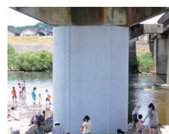
鋼板巻立ての 防錆塗装
