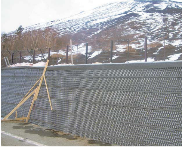
前面側(施工中)
