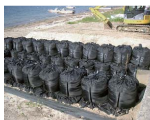
排水路確保のための土留め
