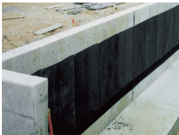
擁壁裏込排水工
