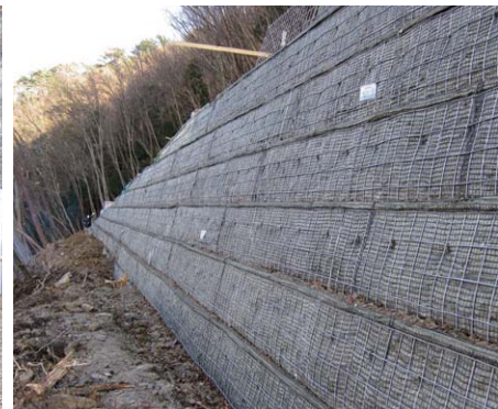
林道工事事例 ・壁面の高さ(m):4.2 ・壁面の勾配:2分
