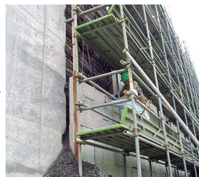
写真-6 新しい壁面材の取り付け
