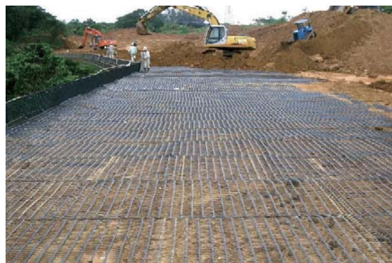
アデム敷設状況
