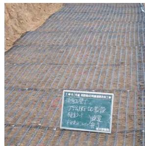
アデム敷設 大分県 市道明野南46号線道路改良工事
