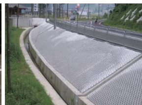
道路のり面保護
