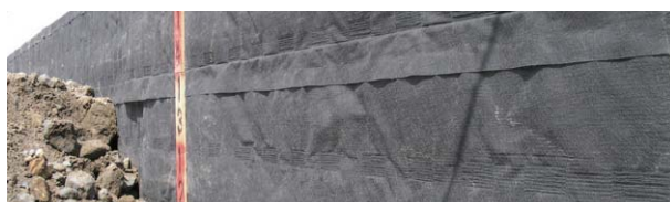
コンクリート擁壁の裏面排水
