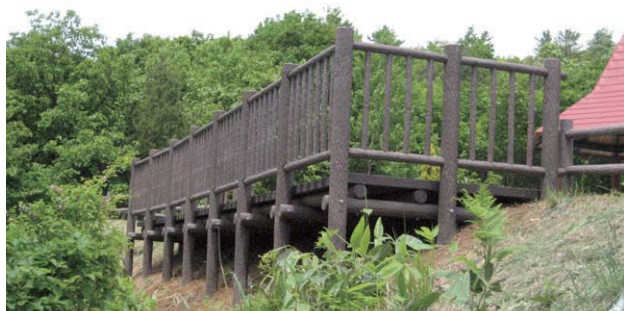
張り出しデッキ
