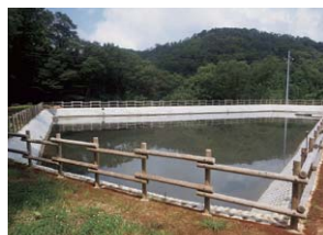
ため池 調整池工
