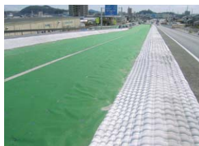
道路のり面保護
