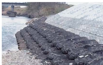
根固工 雄物川(秋田県)
