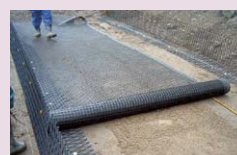
衝撃対応ジオグリッドの延長方向敷設により大きく変形しても崩壊しない。
