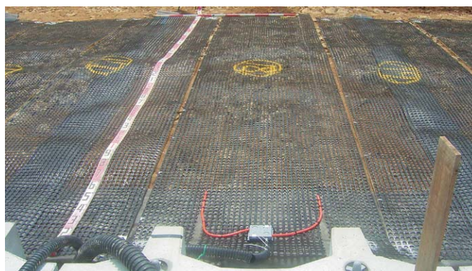
センサーアデム敷設
