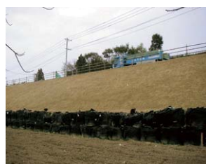
道路の土留め
