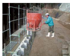
⑦壁面排水層への砕石の投入
