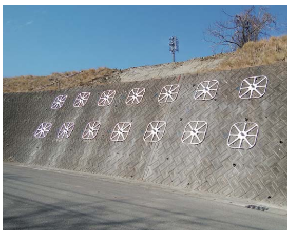
老朽化擁壁補強
