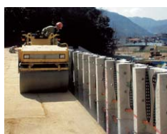
⑥敷均し・締固め
