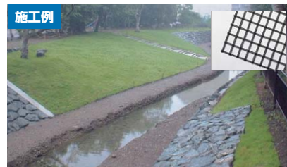
緩勾配低流速河川のジオテキスタイル護岸
