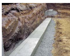
①掘削・整地・基礎工
