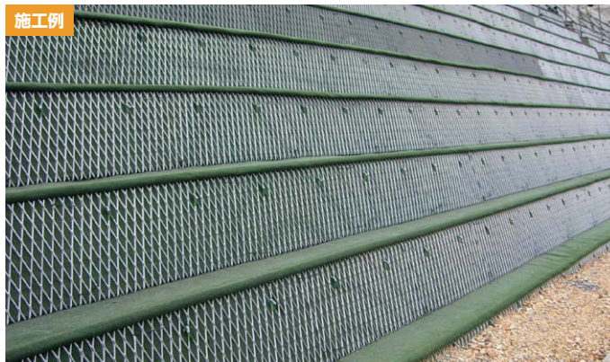
補強盛土の防草および吸出し防止
