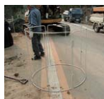
①簡易型枠を設置 ※型枠の貸与は行なって おりません。
