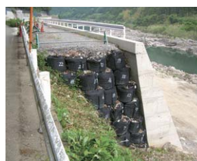
小口の土留め
