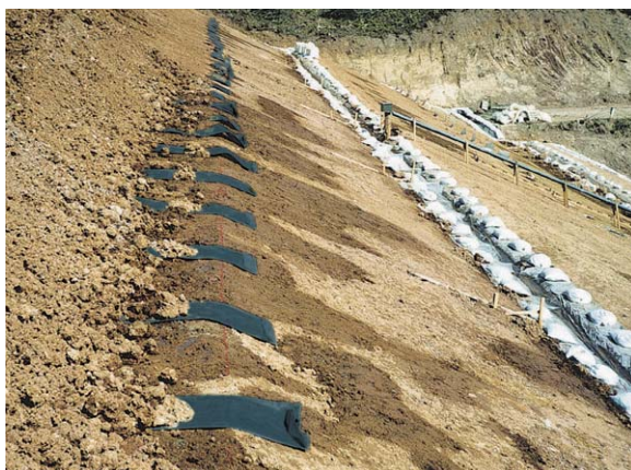
盛土内排水工
