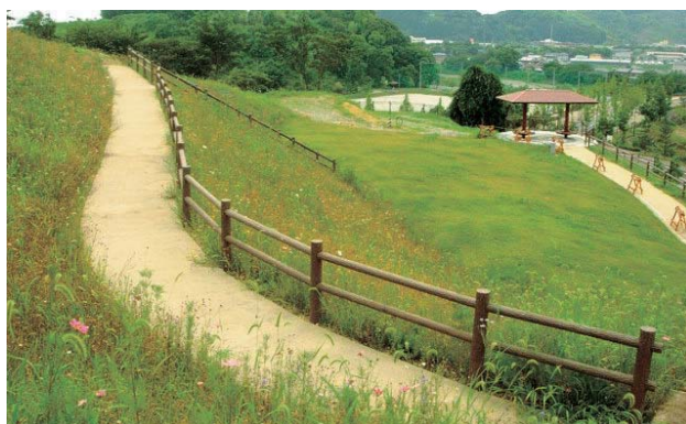
ユニットキャップ工法による盛土の上に設置
