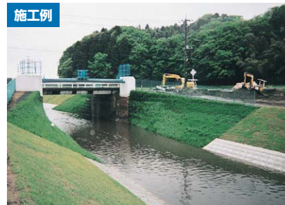
橋脚擦り付け部の施工
