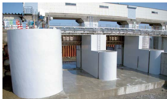
水門の施工例
