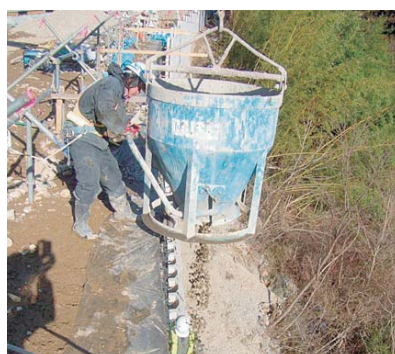
写真-8 壁面排水層への碎石の投入
