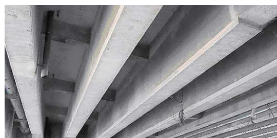
RC主筋の補強
