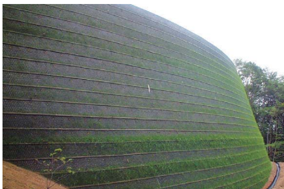
アデムユニットキャップ工法
