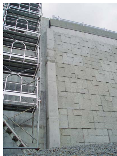
写真-9 補修完了
