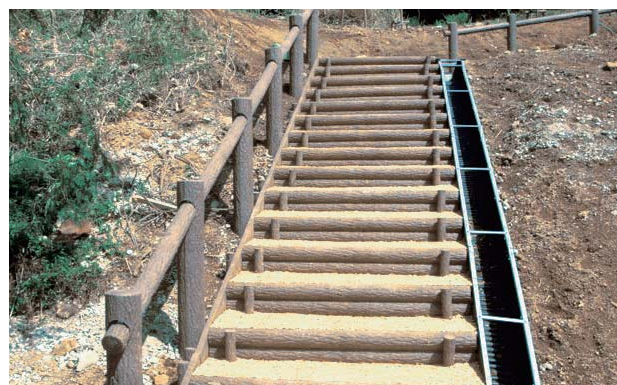
プラ擬木とウッドチップ舗装を使用
