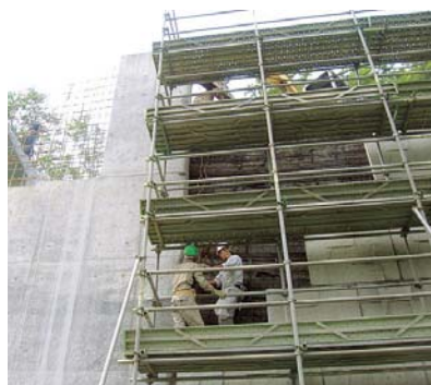
写真-5 壁面材の撤去完了
