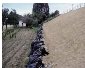
隣接農地への土砂流出防止
