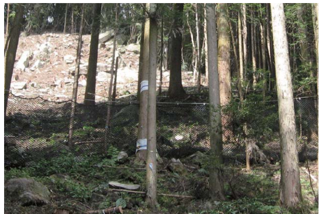
立木タイプ 福岡県 伊良原ダム
