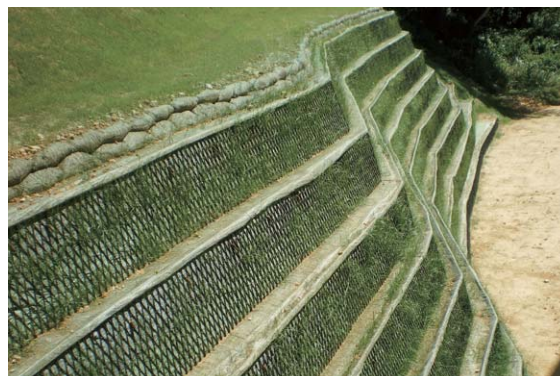
グリーンテラスウォール工法
