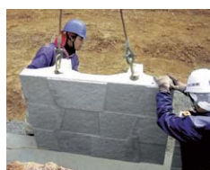
②壁面材の設置・組立て
