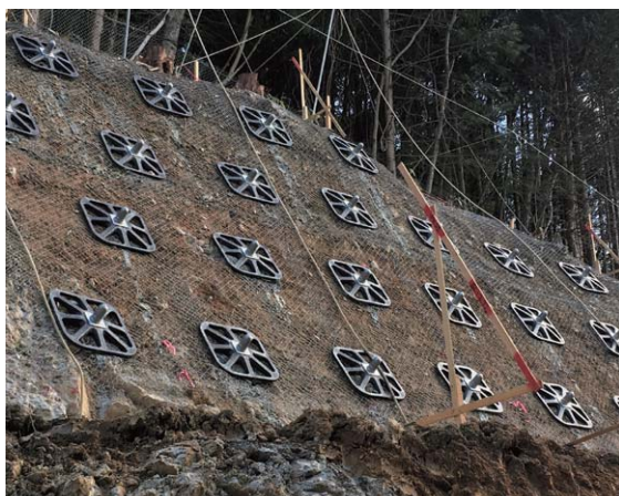
切土のり面補強
