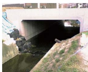
橋架け替え時の旧護岸とのすりつけ部保護
