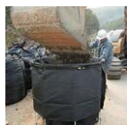
②土砂投入時の 袋引き込み防止の口留め
