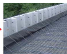
⑤アダムの敷設
