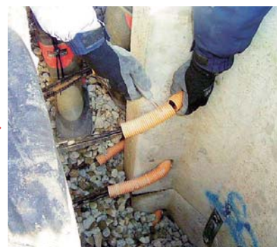
写真-3 グリッドベルトの切断
