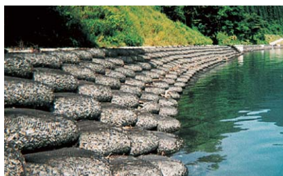
護岸の根固工・洗掘防止 田沢湖(秋田県)
