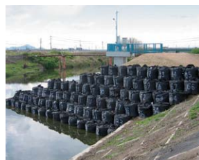
樋門・樋管の改修における仮護岸
