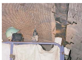
補強筋配置
