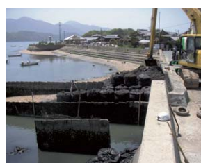
海岸流入水路の両岸土留め
