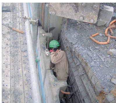
写真-4 壁面材の取りはずし
