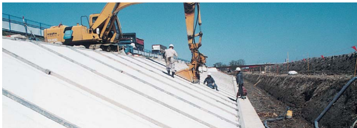
河川・堤防などの、のり面遮水工
