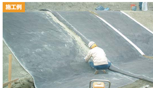
水辺景観工事
