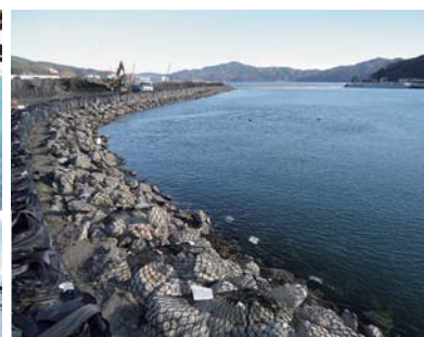
中詰材にコンクリートガラを使用(岩手県)
