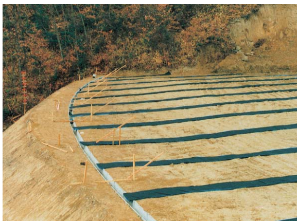
盛土内排水工
