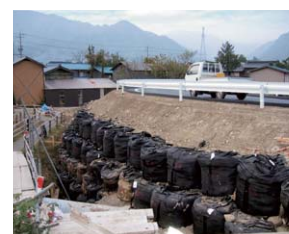
迂回用仮設道路の土留め
