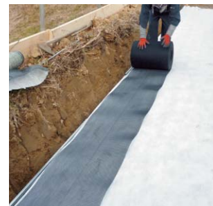
小段補強用ジオネット敷設
