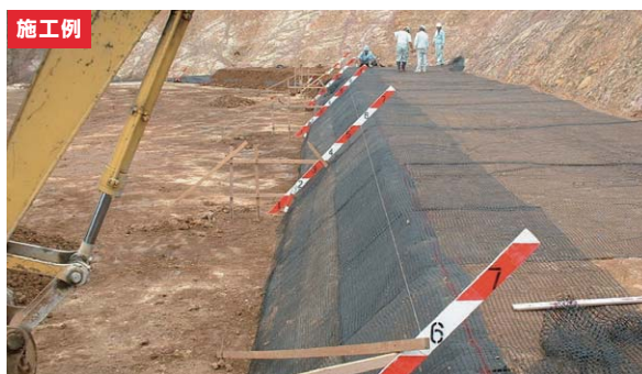
緩勾配盛土の補強
