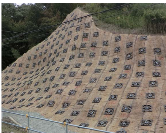
切土のり面補強
