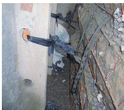
写真-7 壁面材とグリッドベルトの連結
