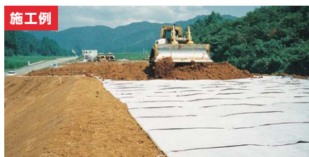
盛土の補強・排水
