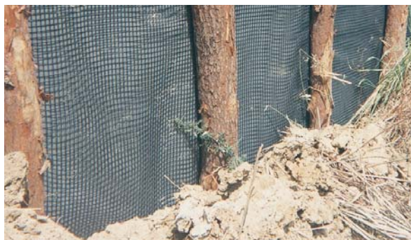
スミネットしがら：編柵工（土留工）
