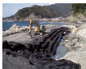
工事用仮設道路
