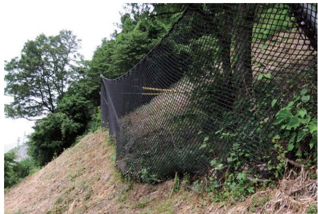
支柱タイプ(落石・崩壊土砂 補促事例) 福井県 福井市 浜北山町
