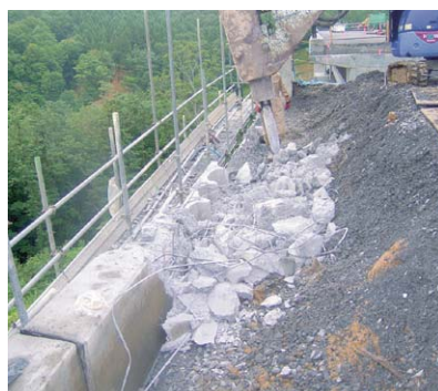
写真-2 笠コンクリート取り壊し
