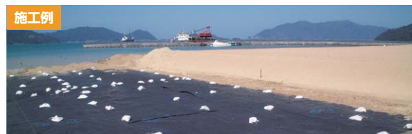
河川や港湾護岸の吸出し防止・洗堀防止
