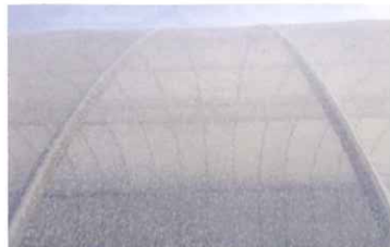
吹き付け後のフィルム表面
