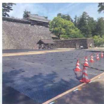
文化財敷地養生
