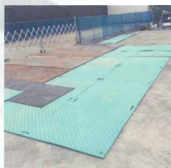
建設現場入口
