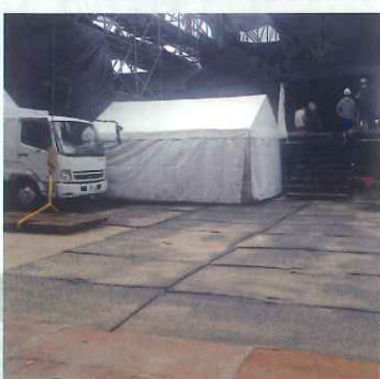
イベントステージ設置工事
