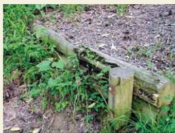
腐朽が進行した木製ステップは大変危険です。ナベシマのPCギ木ステップはコンクリート製なので施工後も長く丈夫に使い、安全に足元をサポートしてくれます。
