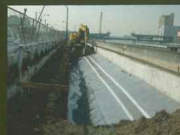
護岸整備の防根
