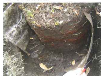
シートを剥がした根の状況
