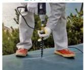
ピンをシートに打ち、インパピン天面がシートとフラット クトレンチでねじ込みます。 ソケットはピン天面ボルト 部分に垂直に深く差し込ん で下さい。
