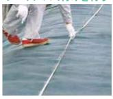
ピンを打つ間隔を決め、印 を付けていきます。線がまっ すぐだと、仕上がりの印象が 美しくなります。
