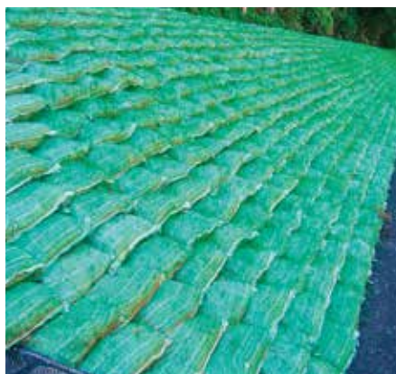
土留グリーンバッグ工
