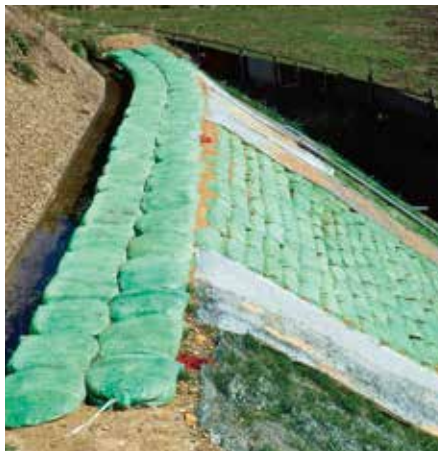
法面崩壊部分の埋戻し
