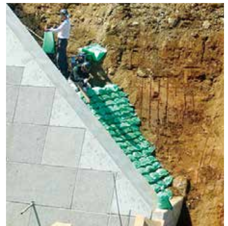
擁壁裏の土砂流出防止
