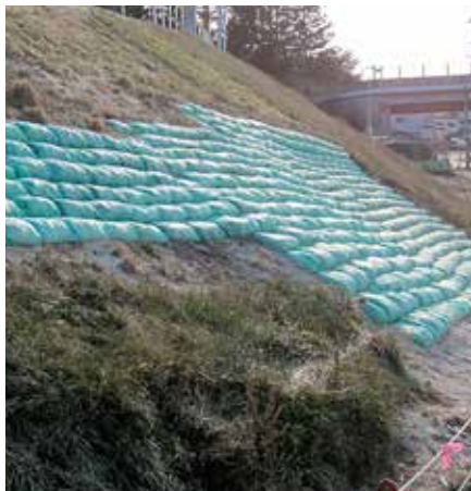
法面崩壊部分の埋戻し
