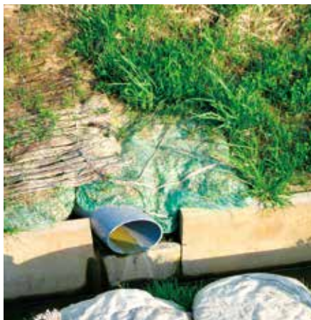
湧水箇所の崩壊防止
