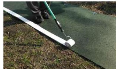
シートの重ね合わせ部分の下側にローラーを転がして貼り付け。
