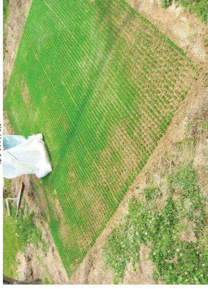
散水する (砂を締める,芝を開かせる)
