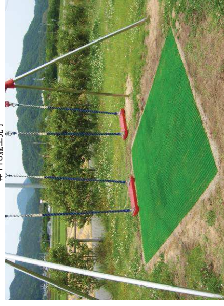
人工芝生デピロン#118敷設 H21.5 アンカーウイ打ち
