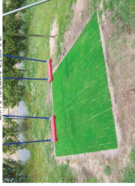
散水する (砂を締める,芝を開かせる)
