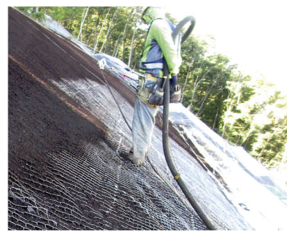
ドレーンシートR設置後の植生基材吹付状況
